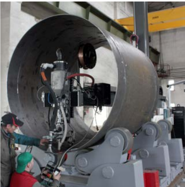
Wewnętrzne spawanie wzdłużne z zastosowaniem słupowysięgnika z zestawem obrotników rolkowych PEMA
